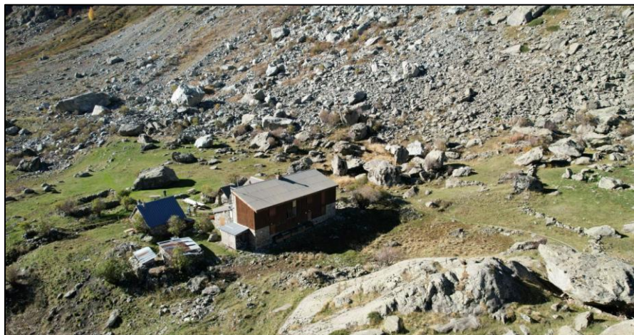
Figure 1 – Vue du réseau de blocs à l'amont du refuge
