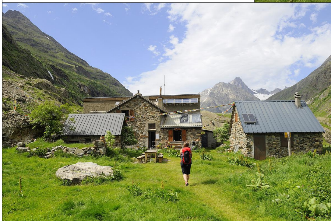
Vue du refuge et du hameau de La Lavey, depuis le Sud, état initial
