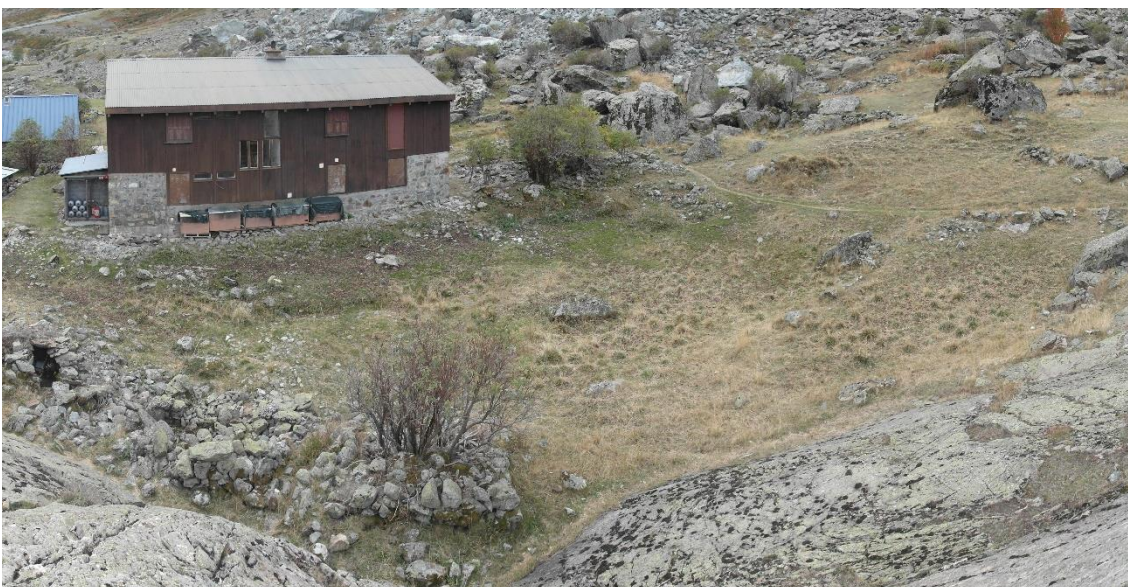
Zone nord du bâtiment ; au premier plan la roche et les vestiges d'un ancien abri - Source Karum 22/06/01
