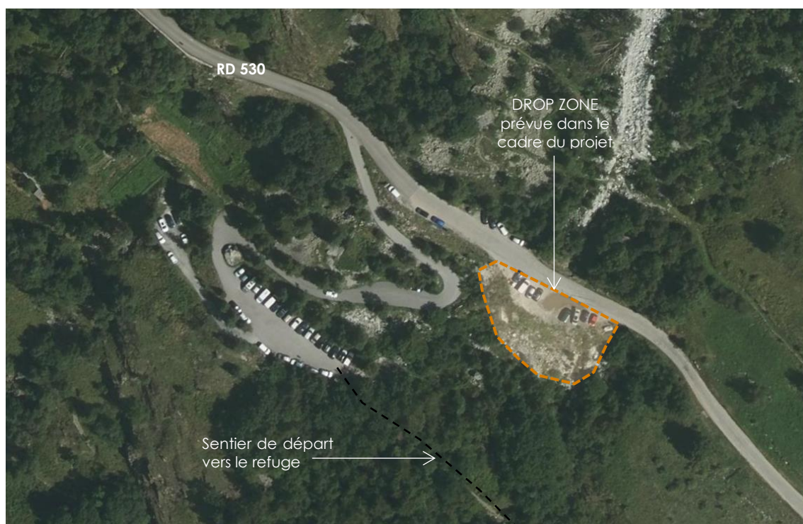
Le parking et la zone prévue de dépôts des matériaux dans la cadre du projet de rénovation et extension - Source Karum
