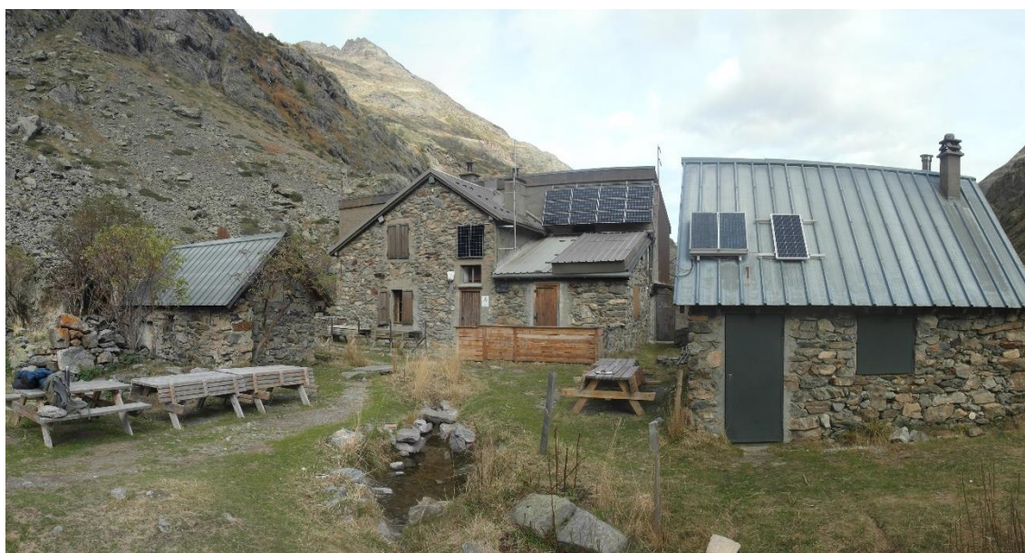
Hameau de la Lavey ; photo de la façade sud du refuge. Source A17c 17/10/23
