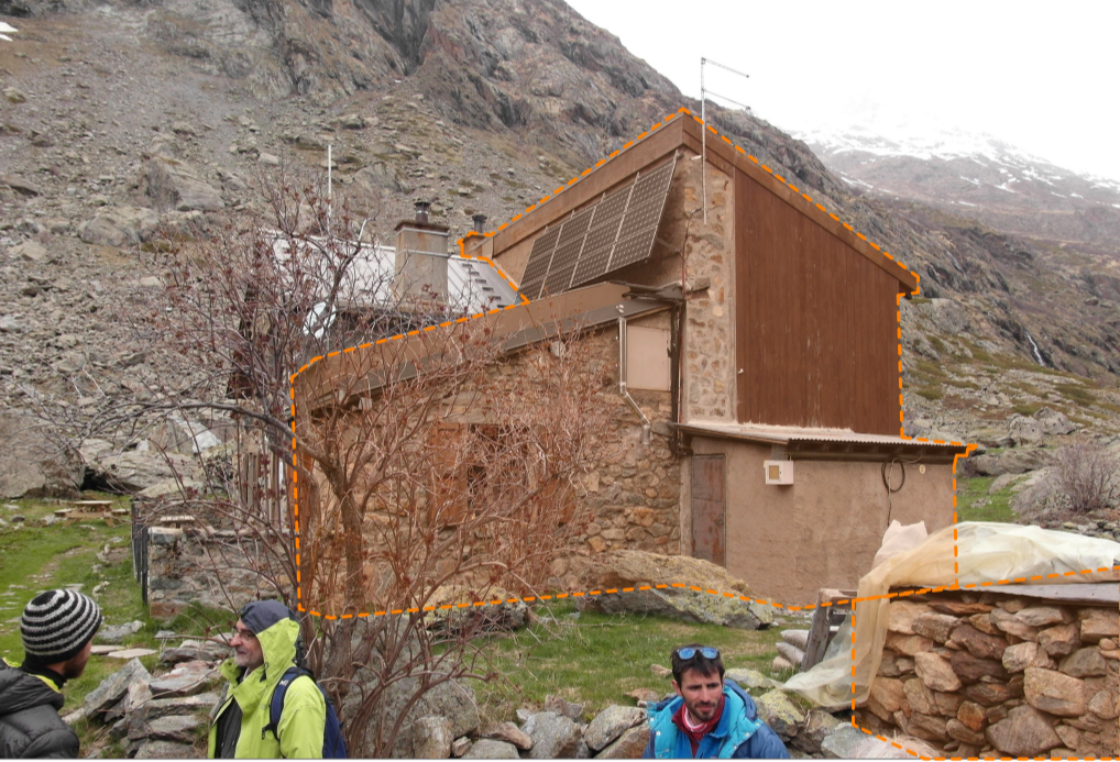
A2.1 - vue depuis l'Est : extension 1968, appentis cuisine et locaux technique
