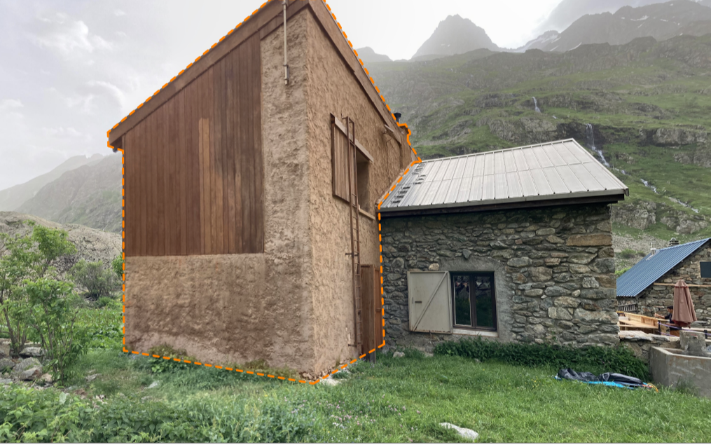
A2.2 - vue depuis l'Ouest (extension 1968 à démolir)
