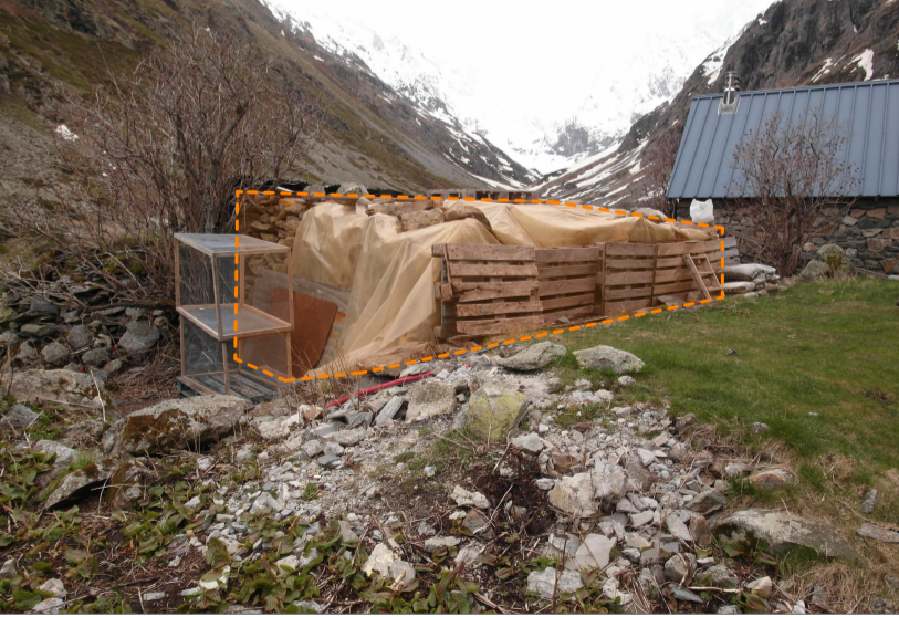
A2.2 - vue appentis stockage depuis le Nord
