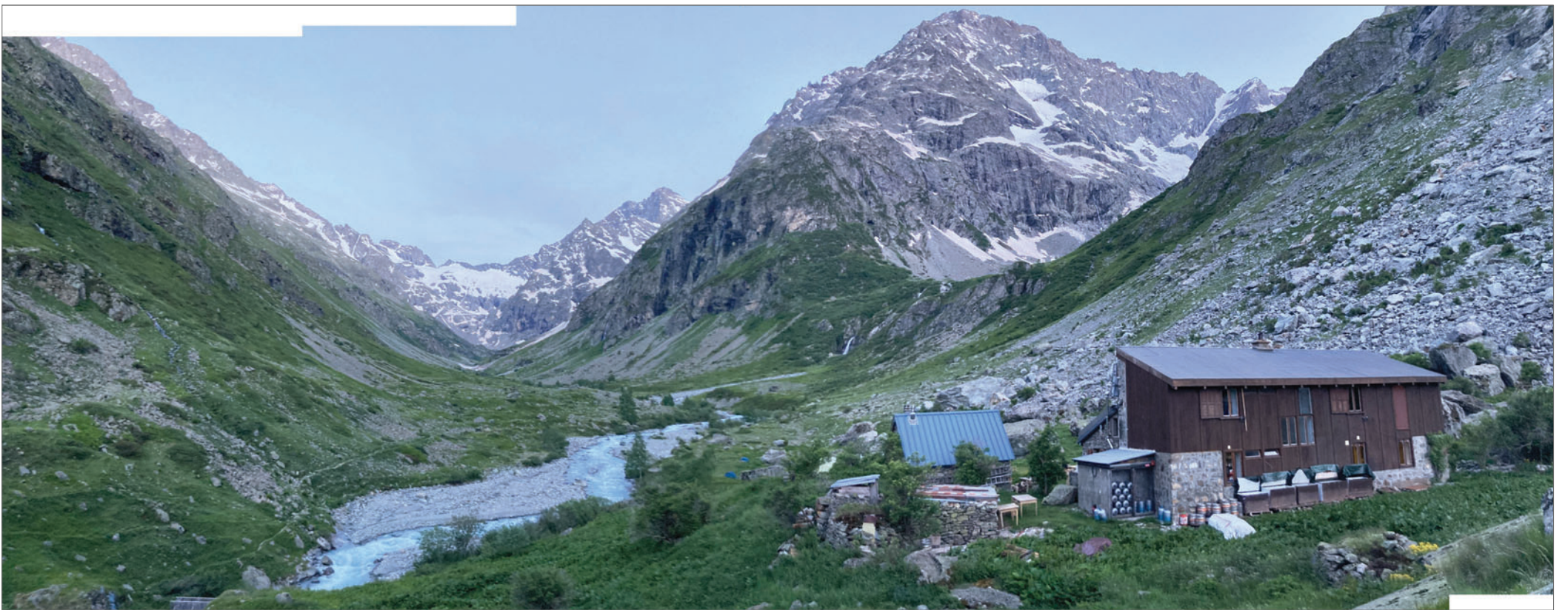
Photographie n°1, vue de "l'extension de 1968" du refuge de la Lavey et du hameau, depuis le Nord-Est
