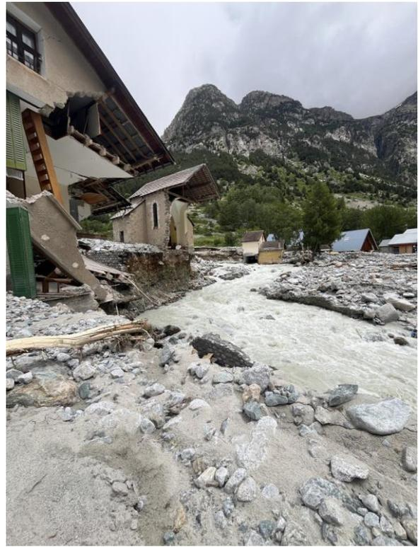
Figure 2: Gauche : bâtiment complètement engravé par la crue, partiellement mis à jour (photo du 17 septembre 2024). Droite : chapelle et bâtiments partiellement détruits par les incisions du torrent des Etançons deux jours après l'évènement, le 23 juin 2024.
